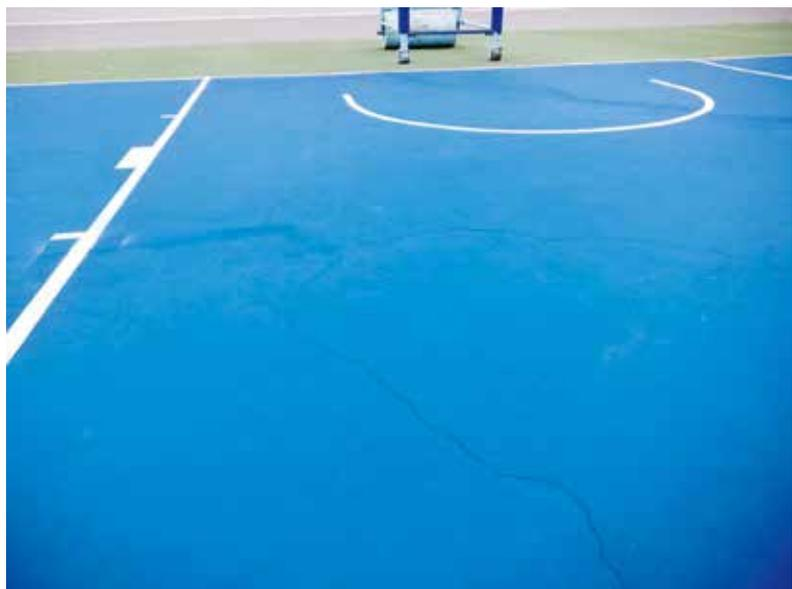
淹水，加上下方是地下停車場，無法用一般球場鋪面底層會使用的 AC 改用混凝土，才會造成鋪面多處龜裂，因還在保固期內，近日就會由廠商重新鋪上壓克力鋪面修復，目前並無安全疑慮，施工修補前仍會開放給民眾使用。
