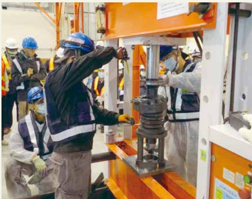
▲捷運綠線新軸心組裝作業已如期完成
